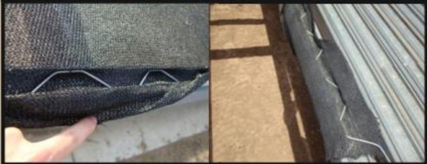
**Figura 5: Sujeción de la malla plástica a la estructura (EEA Rafaela, 2009).**
